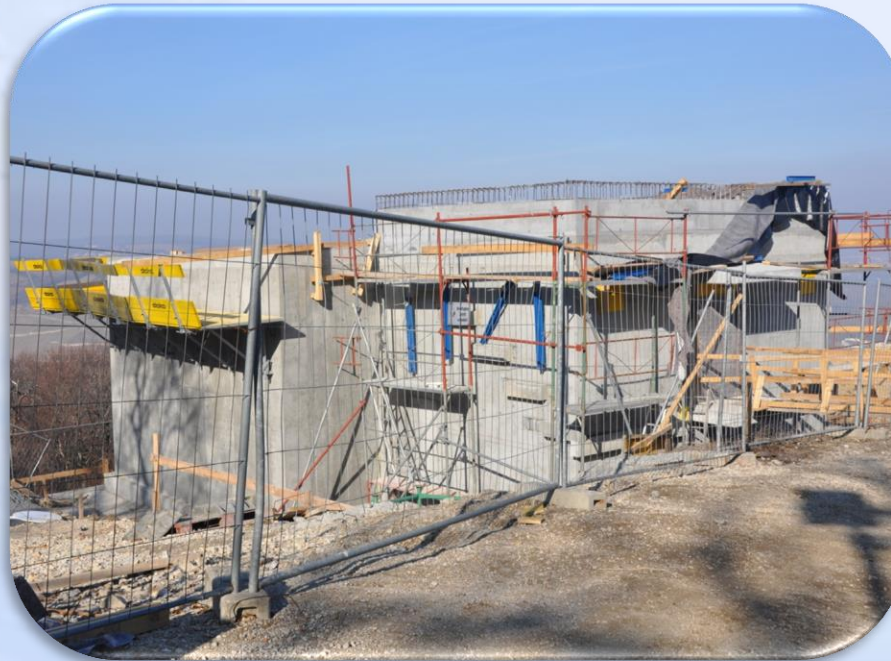
Großbaustelle am Schatthang
